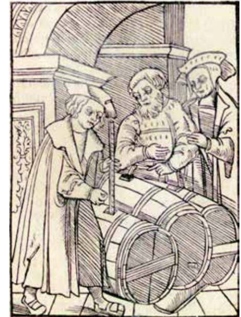
Gebrauch der Quadratrute in: Schreiber, Rechnen unnd Visyr buechleynn , 1523, S. 31 (Bayerische Staatsbibliothek München/Münchener Digitalisierungszentrum)
